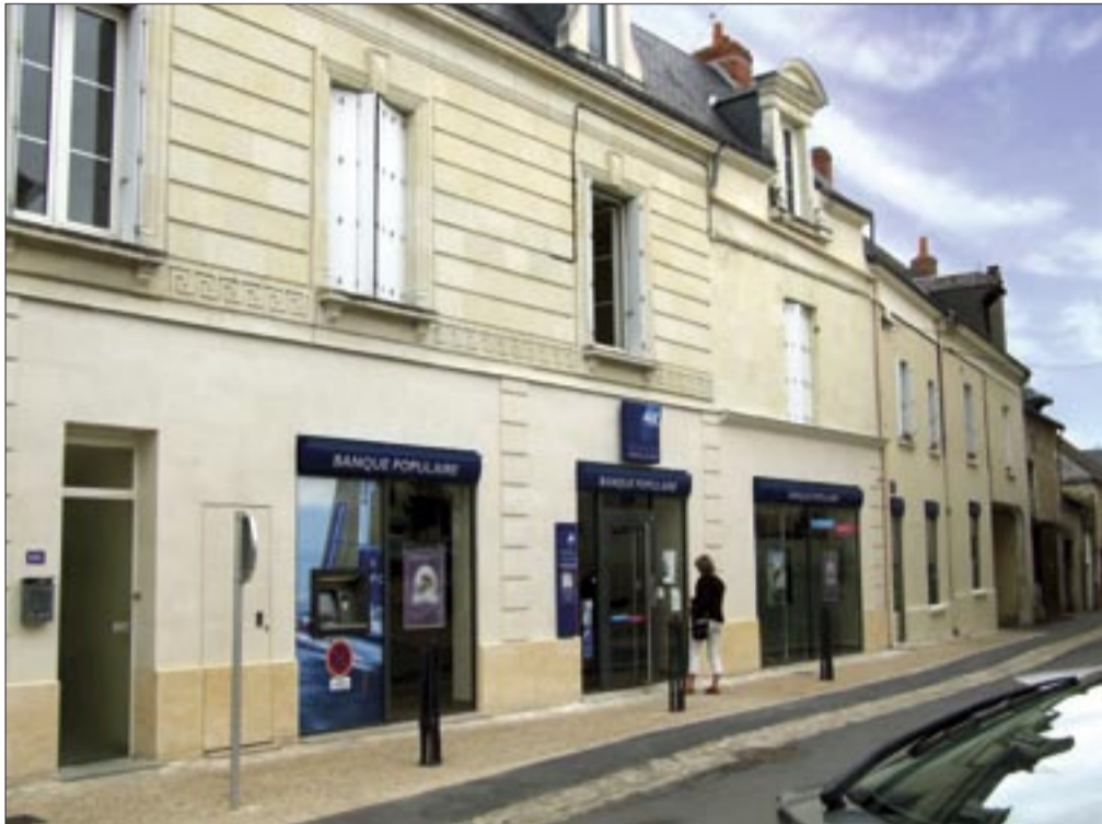
La façade de la Banque populaire a été restaurée avec succès
