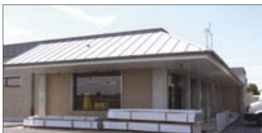
Le bâtiment pendant les travaux
