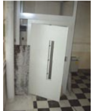
L'ascenseur sera bientôt prêt
