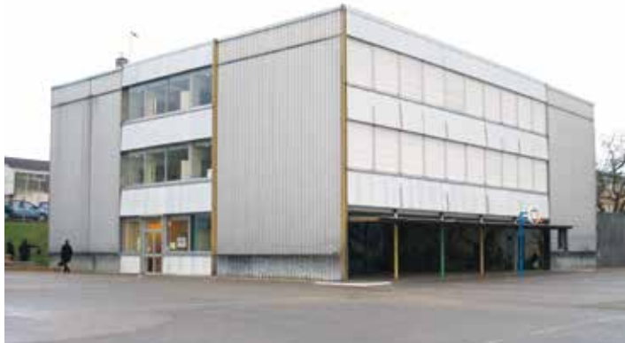
L'école Voltaire avant et après travaux...
