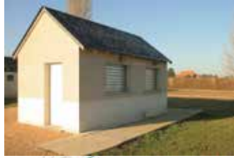
5 Au parc Robert Guignard, construction d'un local pour les boulistes
