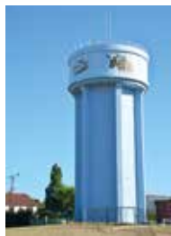
Remise en état du château d'eau et ajout de fresques mettant en valeur les chèvres et le fromage de Sainte-Maure-de-Touraine
