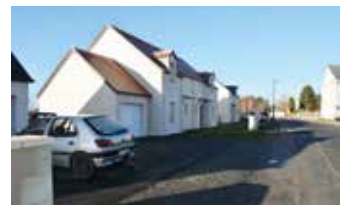
11 Construction de 4 logements route des Coteaux
