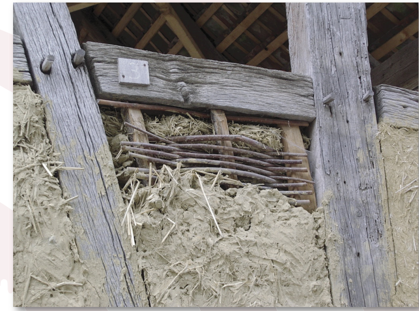
Mise en œuvre de torchis sur palançons tressés - Wattle and daub - Aplicación de adobe sobre entramado 2007 © écomusée d'Alsace-Florival
