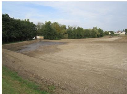
Les travaux ont démarré début octobre. Cela est visible depuis la route RD 760, en direction de Loches. Les bassins créés permettront de recevoir les vases aspirées par une sorte de « suceuse » qui se déplacera dans l'étang. Ainsi, après décantation, l'eau rejoindra la Manse lentement. Cette opération durera plus d'un mois au total. L'entreprise en charge de ces travaux se nomme AQUANET PLUS.
