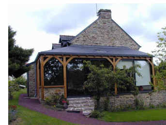
Véranda avec mur de soubassement
