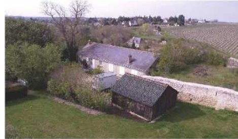
Implantation de panneaux solaires sur l'intégralité d'une annexe d'habitation
