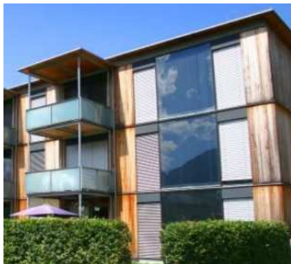
Utilisation de panneaux solaires en tant que fenêtres
