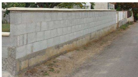
Mur en parpaings
