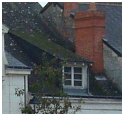
lucarne rampante ou en chien couché
