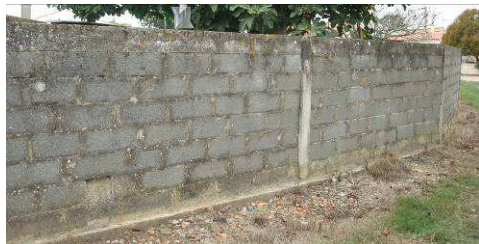
Mur en parpaings
