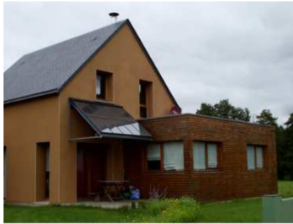
Création d'un auvent ou d'une pergola pour accueillir des panneaux photovoltaïques
