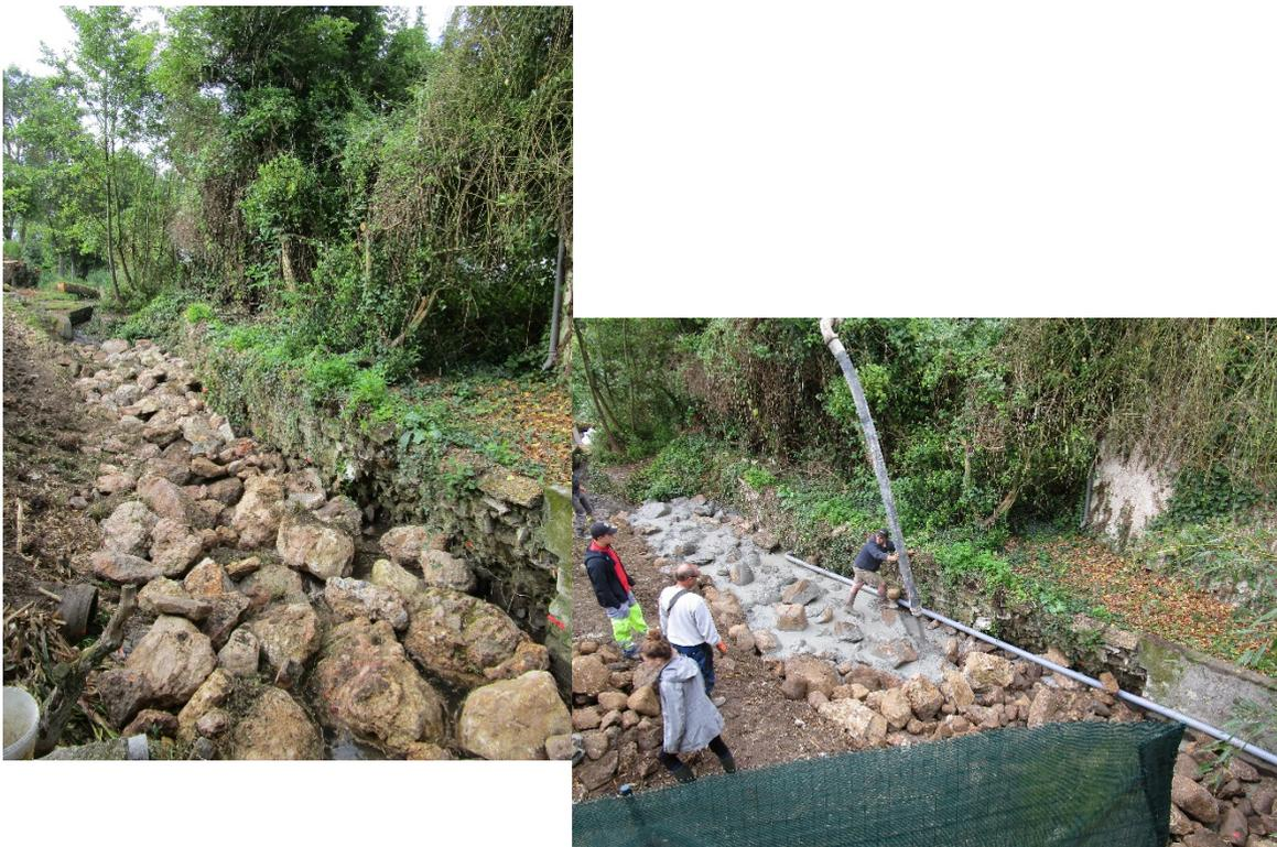
*Création de la rampe en enrochement et béton dans le ruisseau mis temporairement à sec*
