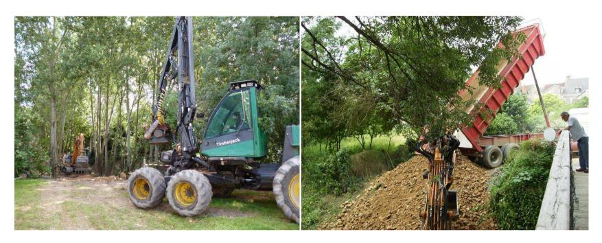
Pour réaliser les travaux d'aménagement de berges, du lit et de chutes d'eau, différents engins sont intervenus durant les travaux, pour l'abattage des peupliers (à gauche), l'apport de pierres issues de carrières (à droite).
