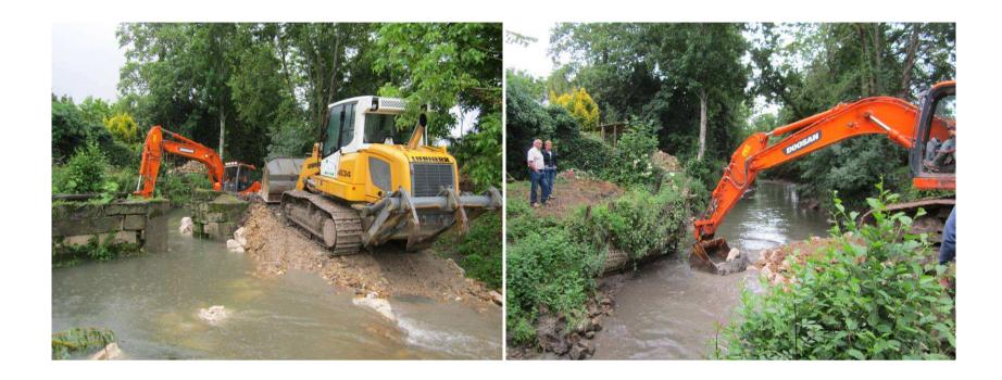
Pour aménager les rives en pente douce, en lieu et place des anciennes planches, d'autres engins déposent de la terre et des pierres dures. Ces matériaux sont dispersés de manière très précise, selon la profondeur du ruisseau. Le fait de rétrécir ainsi le lit permet de rehausser le niveau d'eau.
