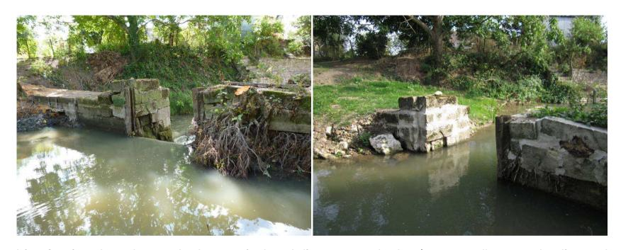
Ce seuil était fermé par de nombreuses planches, jusqu'en haut de l'ouvrage. Ces planches, (y compris celles encore dans l'eau sur la photo de gauche), ont toutes été enlevées. Les murs de part et d'autres de l'ouvrage ont été nettoyés et rejointés après le dessouchage des arbres.
