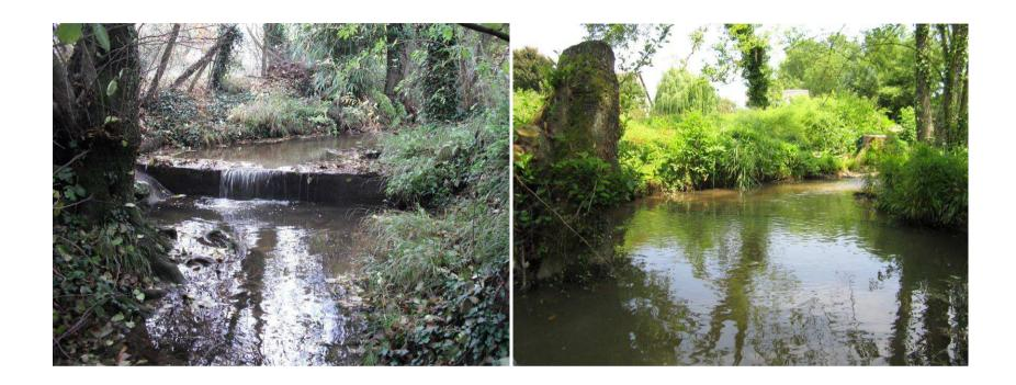
Ce seuil bétonné, de 40 cm de hauteur, contient un réseau d'eaux usées. Il n'était donc pas possible de le casser. La pose de 30 m<sup>3</sup> de granulats, sur une vingtaine de mètres en aval, a rehaussé le niveau d'eau et estompé la chute d'eau. Les poissons peuvent désormais remonter le cours d'eau.
