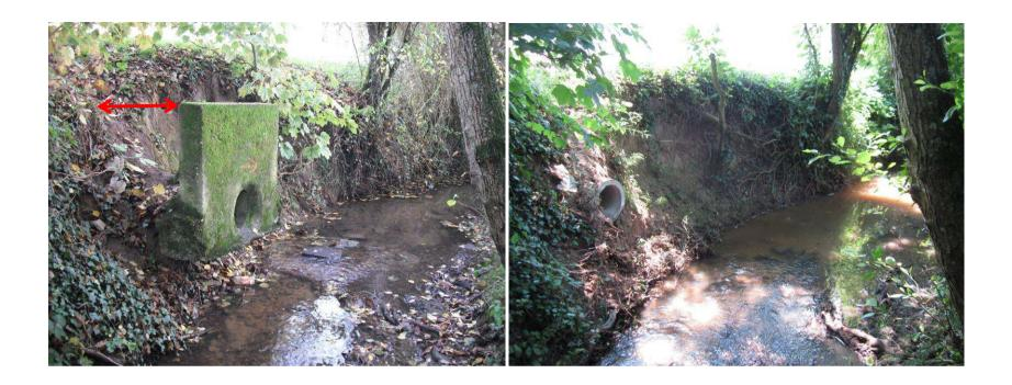
La flèche rouge montre l'évolution de l'érosion de la berge en 40 ans : 120 cm soit 3 cm par an. La structure béton a été évacuée avant qu'elle ne tombe dans le lit de la rivière et l'obstrue.
