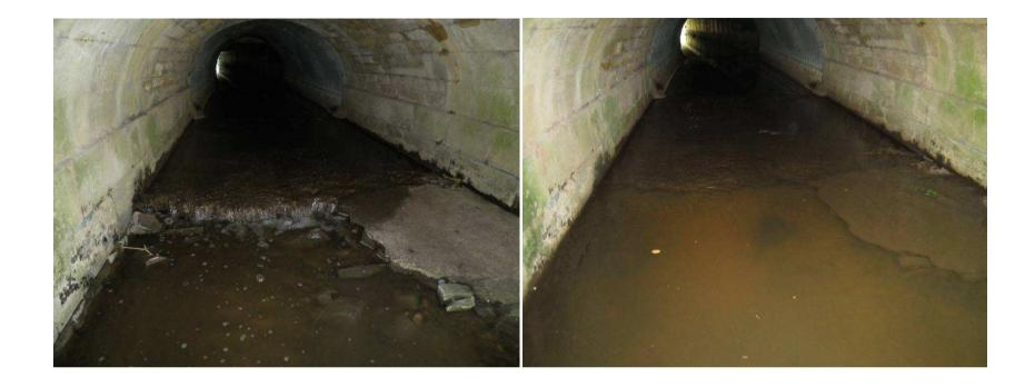
La pose de quelques granulats \*\*\* une dizaine de mètres en aval a rehaussé le niveau d'eau et estompé la chute d'eau (photo de gauche : seuil cimenté de 20 cm de hauteur - sous le pont de la rue de Loches). Les poissons peuvent à présent remonter le ruisseau.
