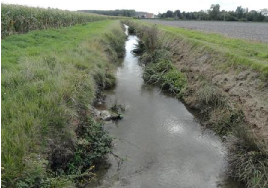
Le cours d'eau à Maillé trop large donc envasé et dont les berges trop abruptes s'érodent
