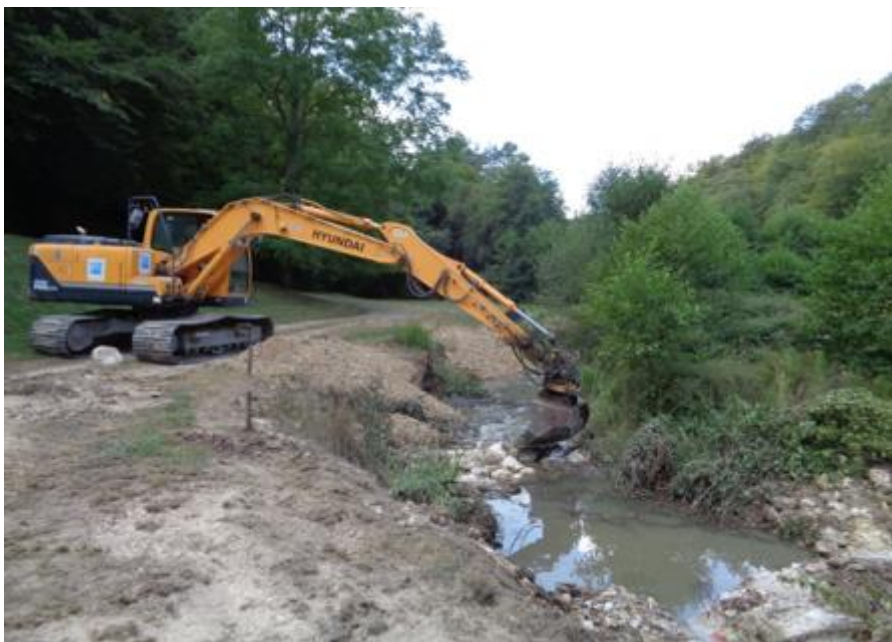
Travaux en cours au domaine du Croulay à Panzoult
