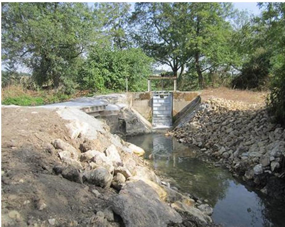
Vue de la nouvelle vanne (en lieu et place de l'ancienne). Sur la gauche, nouveau déversoir créé
