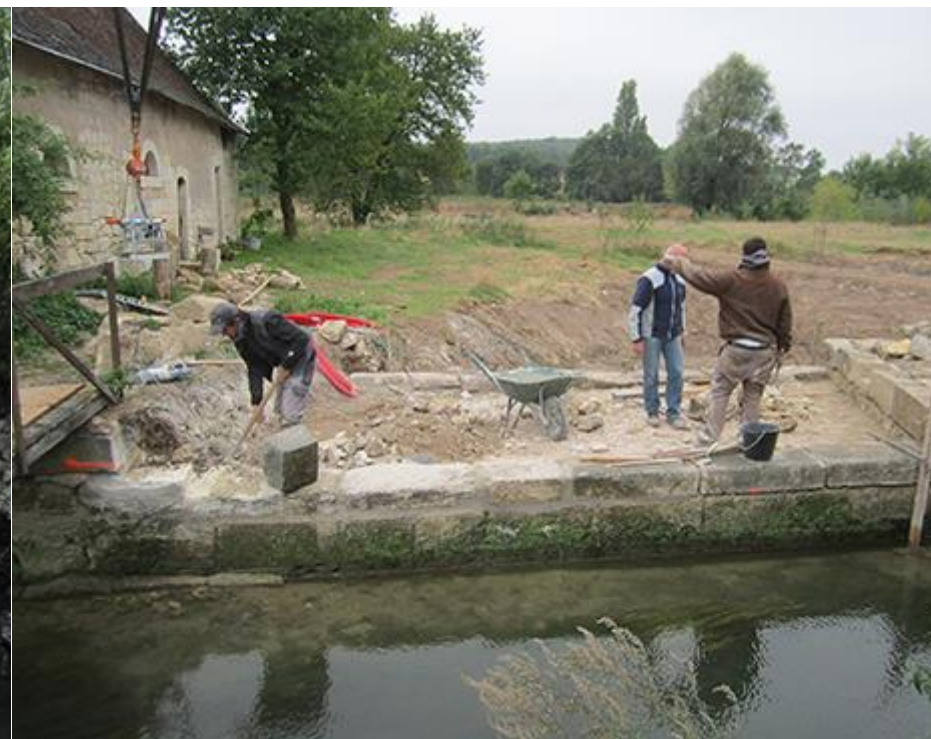
Abaissement du déversoir du moulin de 20 cm
