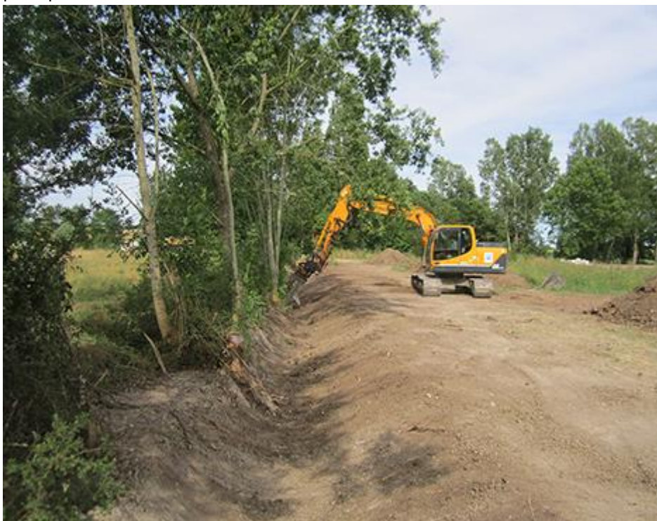
Restauration d'une annexe hydraulique (fossé évasé) entre deux bras de Manse
