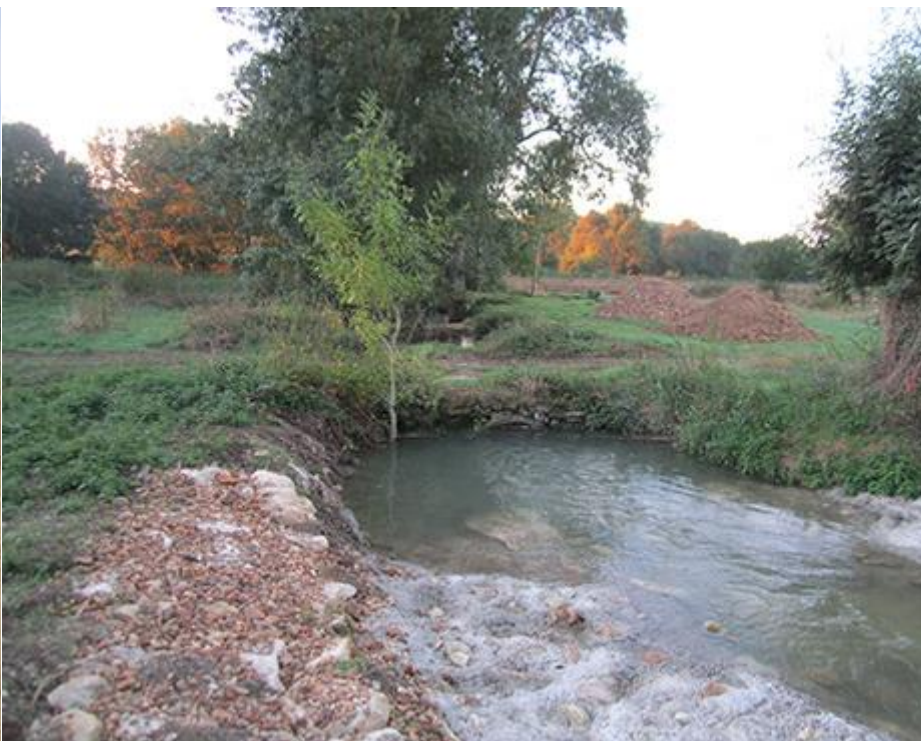
Vue du bras de décharge avant travaux. Le passage busé limite les débits. La buse a été ôtée.
